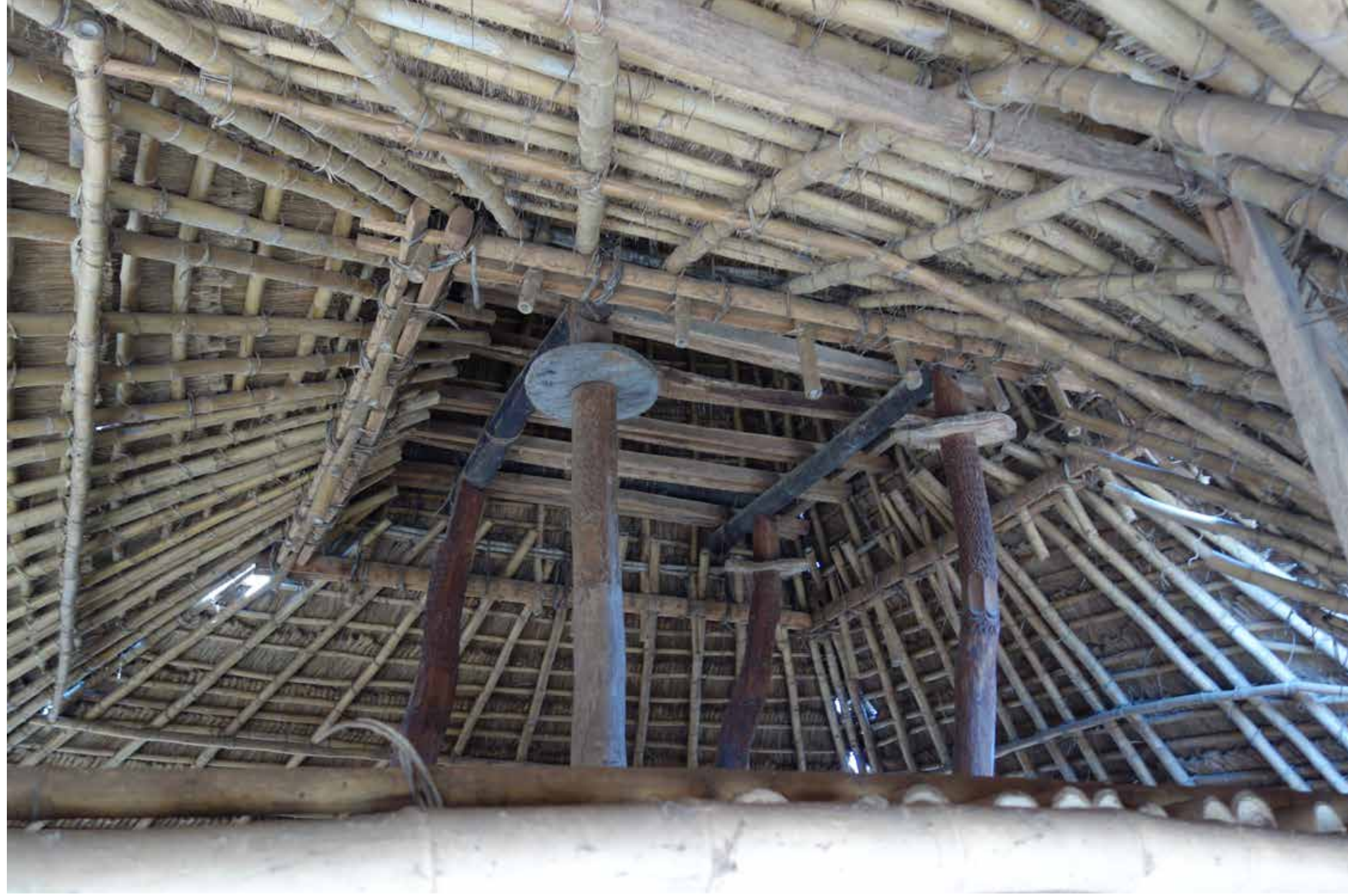
Fig. 4 : Village de Wainyapu à l'extrémité ouest de l'île (district Kodi), maison récemment abandonnée. Détail de la charpente en bois et en bambous ainsi que des quatre piliers principaux qui la supportent. Ces piliers richement sculptés sont surmontés de rondelles en bois et sont liés par de fortes poutres qui servent de base à la tour. © Anthony Denaire, 2018
