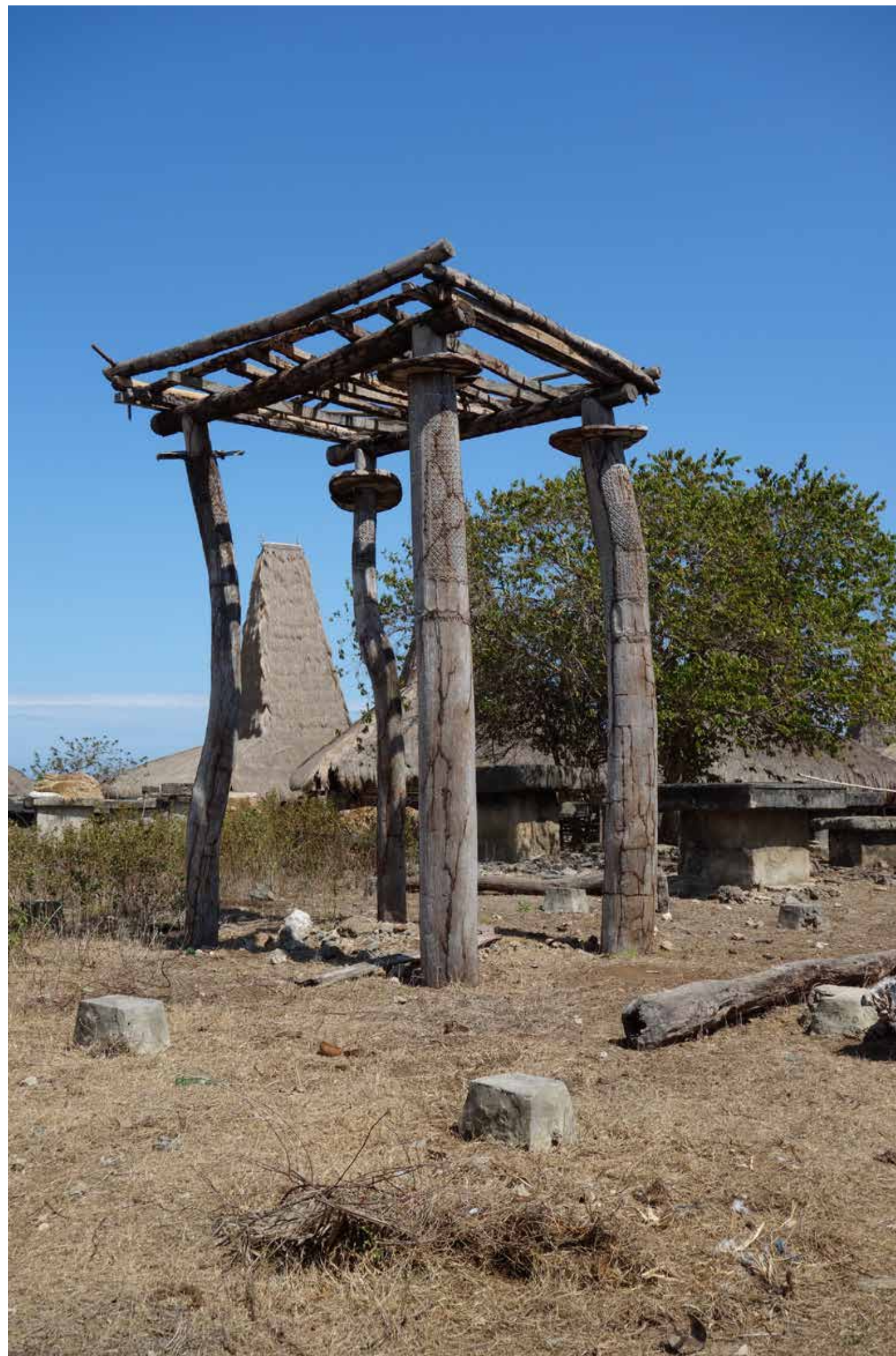
Fig. 6 : Village de Wainyapu. Ce qui reste d'une maison après plusieurs années d'abandon : les quatre piliers principaux et quelques plots, non encore réutilisés, qui supportaient les autres poteaux. À l'arrière-plan, plusieurs tombes mégalithiques. © Anthony Denaire, 2018
