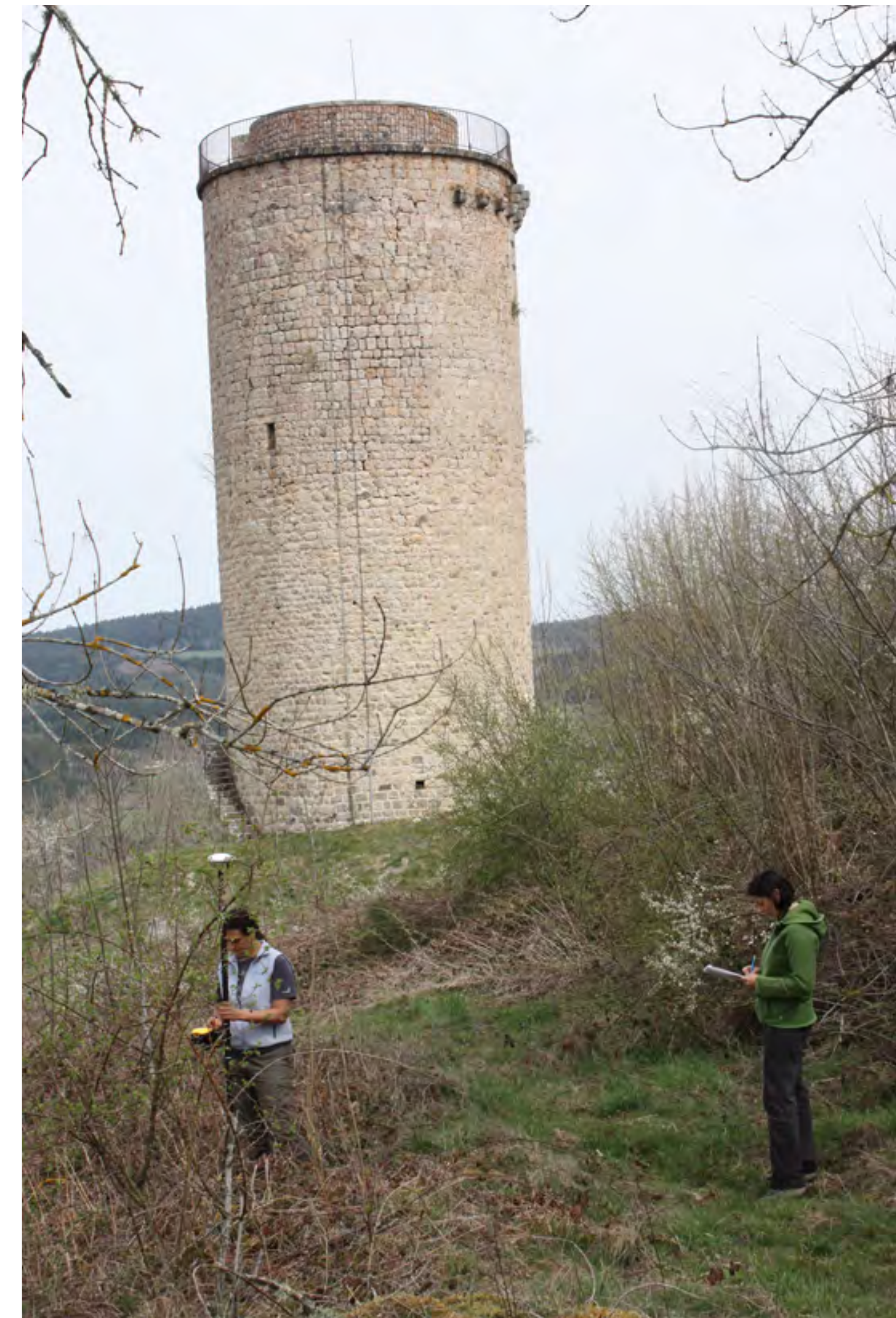
Fig. 3 : Tour dite « de Joyeuse » encore en élévation sur le site. © Mélinda Bizri
