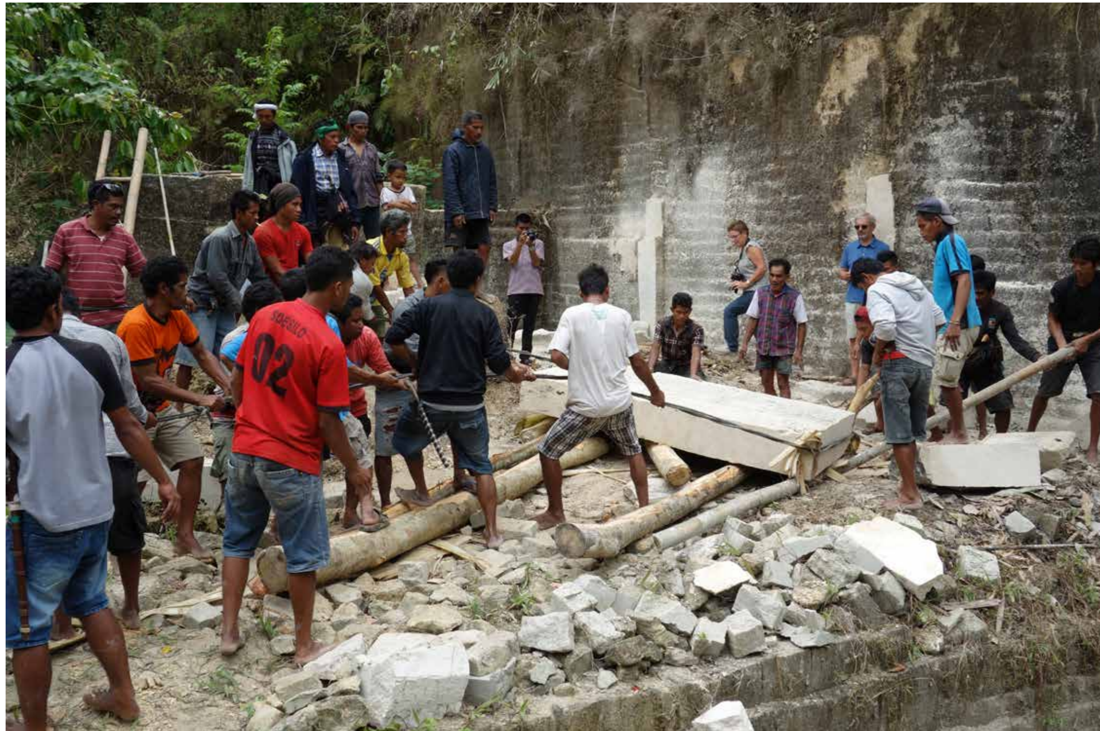
Fig. 3 : Carrière à l'est de Waikabubak (district Lolli). La dalle est sortie de la carrière à l'aide de cordes. Elle glisse sur des troncs de palmiers placés longitudinalement qui forment un chemin plus régulier et praticable que le sol de la carrière jonché de débris. Ces troncs sont repositionnés au fur et à mesure de l'avancement de la dalle. Les leviers permettent de contrôler la trajectoire du bloc. L'homme qui se tient juste derrière le bloc est le carrier : par ses chants, il amorce et coordonne l'effort des tireurs. © Anthony Denaire, 2018
