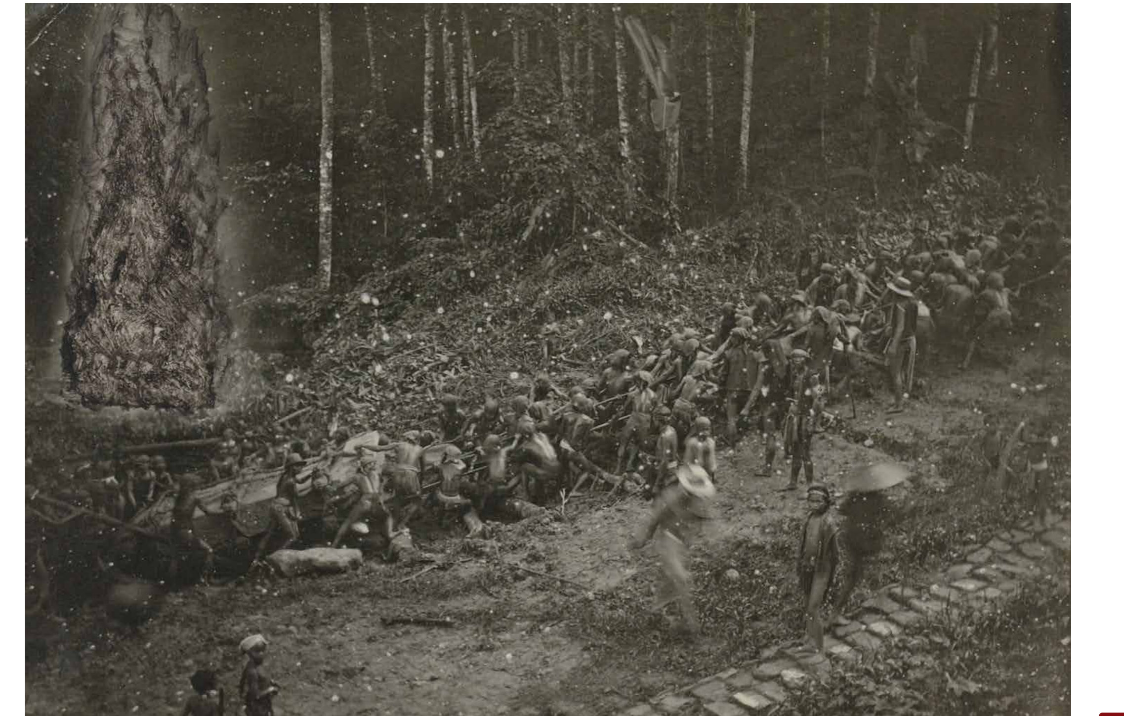
Fig. 6 : Alentours du village de Bawomataluo, au sud de l'île de Nias, située à environ 2500 km au nord-ouest de Sumba. Photographie du début du XX e siècle montrant le tractage d'un bloc reposant sur un traîneau en bois. Pour limiter les frottements, le traîneau glisse sur des rondins de bois disposés transversalement. © J. Borutta - Musée d'Ethnologie de Leyde
