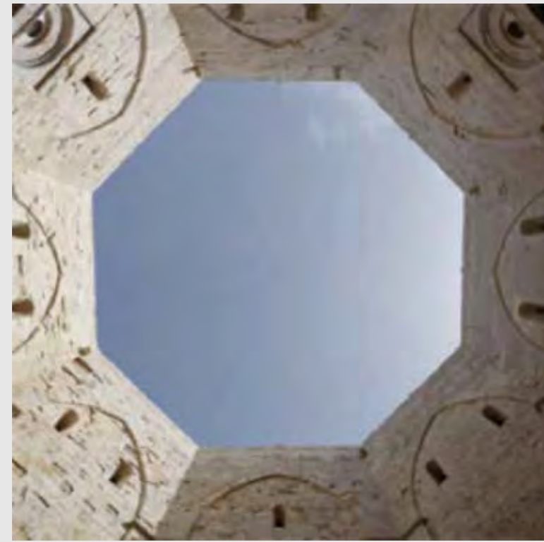
Vue en contre-plongée de la cour intérieure du Castel del Monte, château italien du XIII e siècle construit par l'empereur Frédéric II.
