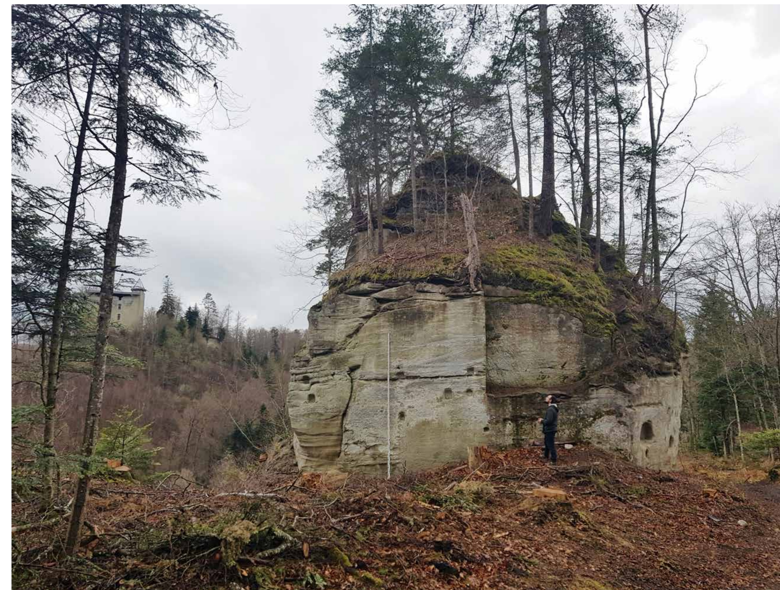
Vue du piton molassique aménagé en cours de modélisation - Arconciel (Suisse) (cliché Mélinna Bizri).
